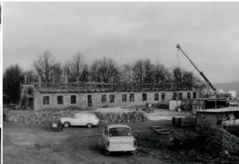
Rohbau der neuen Geschäftsstelle, Bezug 1987
